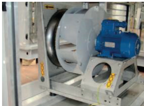
Рисунок 3. БЛОК ВЕНТИЛЯТОРНЫЙ
