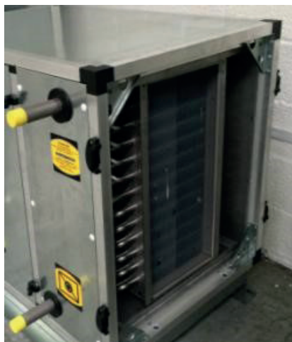
Рисунок 6. ПАРОВОЙ ВОЗДУХОНАГРЕВАТЕЛЬ
